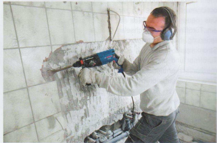
Fliesenleger Carlo Markowski aus Münster hat den GBH 2-24 D Professional beim Abbruch von Wandfliesen getestet und sich von der Geräteleistung überzeugt.
