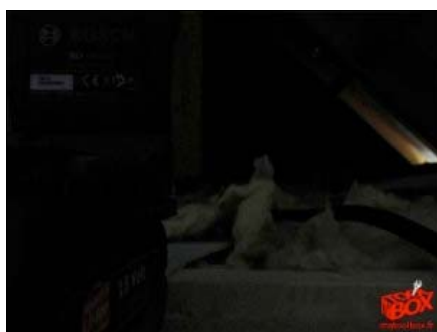
Un comble perdu sans éclairage - Cliquez pour agrandir!
