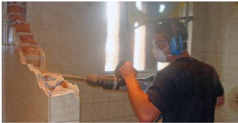
Leerling Rene Kusters test de Bosch breekhamer GSH 11 bij de sloop van een baksteenmuur met tegels.
