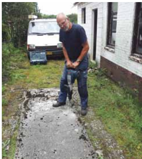
Hans Martijn test de GSH 11 VC Professional breekhamer op een strook beton.
