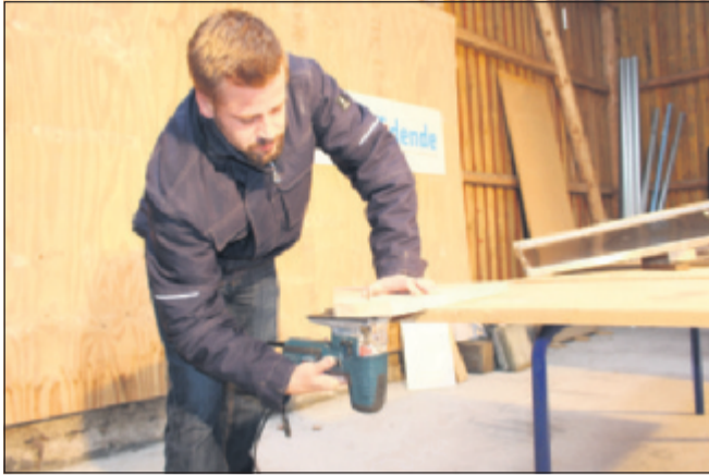
Stiksaven er let at arbejde med og kan føres meget præcist.
