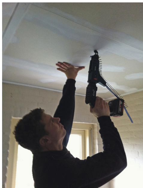
Mathijs Raaijmakers aan het werk met de accudroogboorschroevendraaier met het magazijnopzetstuk MA55 Professional voor Bosch-schroefbanden.
