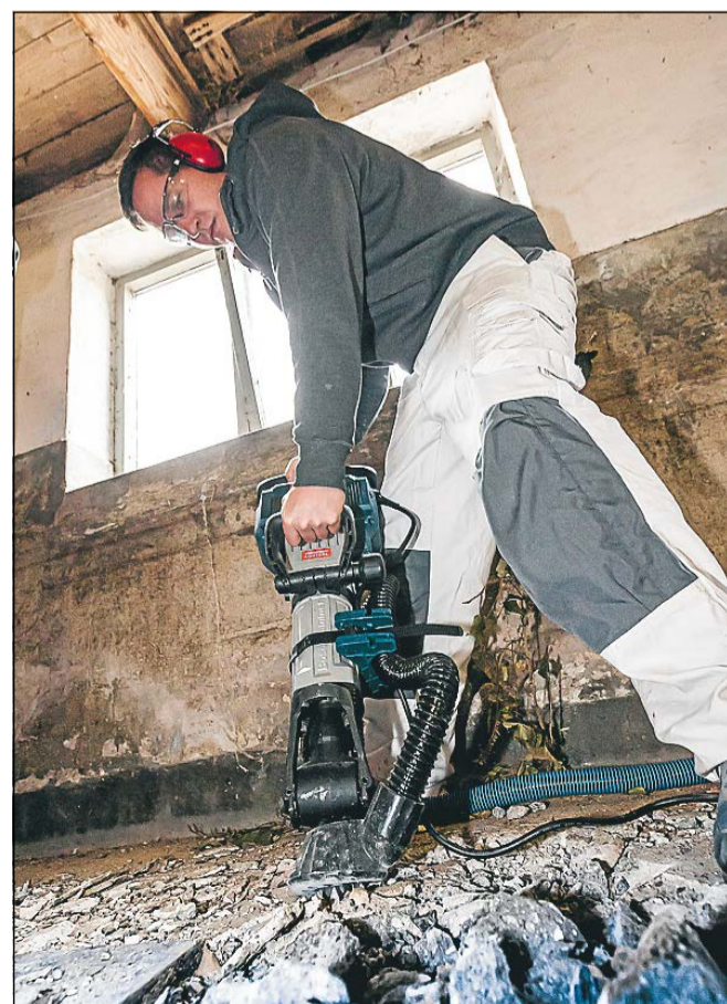
Bosch udsugningsudstyret passer til alle mærker af nedbrydningshamre
