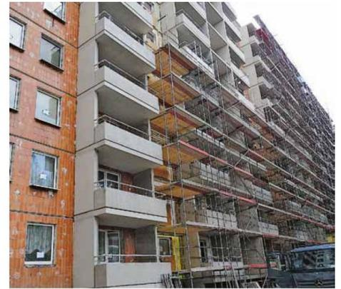
Die alten Balkone wurden entfernt, neue Balkone und Loggien werden angebracht. Die Mahlo Bau GmbH ist das bauausführende Unternehmen.
