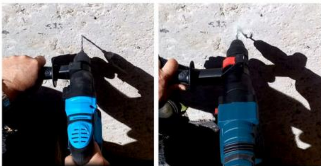
I BETONG: Betong er ikke noe problem, selv for en liten borhammer. (Foto: BRYNJULF BLIX)
